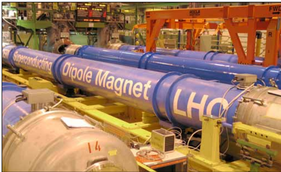
Een deel van de ondergrondse installatie in Genève. Foto: UT-Nieuws
